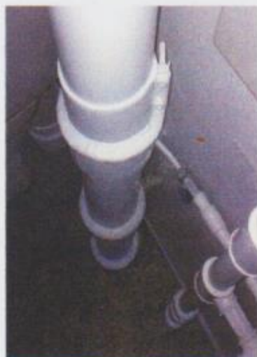
Reparation på faldstamme
