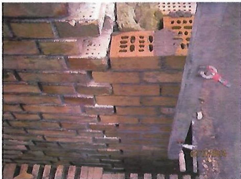
EFTERISOLERING OG NY SKALMUR
