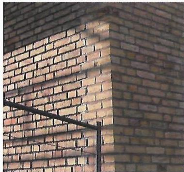
NYT MURHJØRNE INDEN FUGNING
